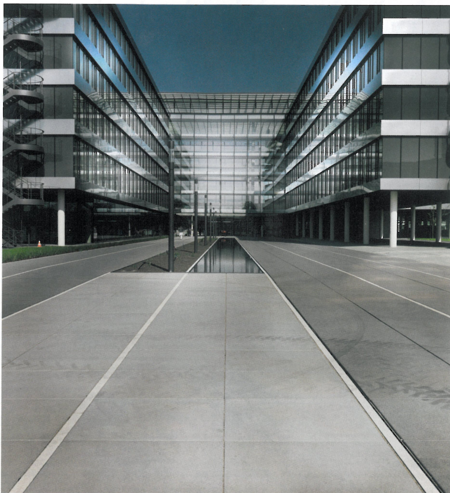
Talanx-Bürokomplex in Hannover: 66 geothermische Sonden liefern 75 % der Heizenergie
